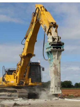
SLOPEN VAN VERSTERKTE BETONCONSTRUCTIES
