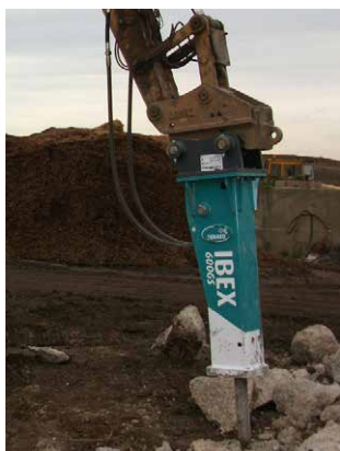
SLOPEN VAN GEBOUWEN
