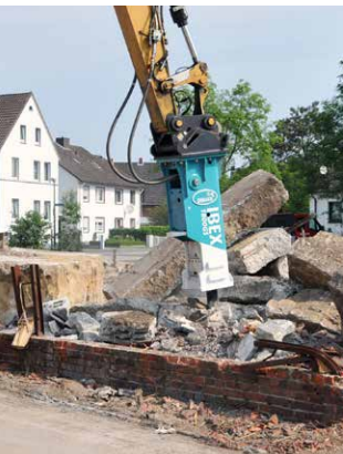
SLOPEN VAN GEBOUWEN
